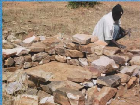
Stabilisation des pierres par du banco avec la bouse de vache et l'huile de vidange
