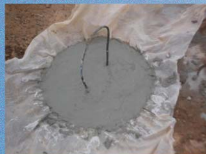
La confection de la couverture du trou de défécation
