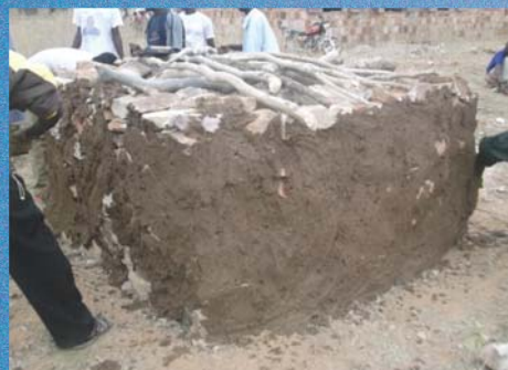
La confection de la couverture du trou de défécation
