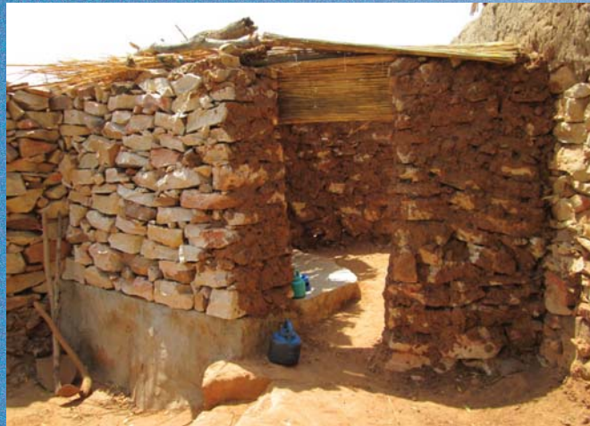
Le maçon taille les pierres pour construire la latrine
